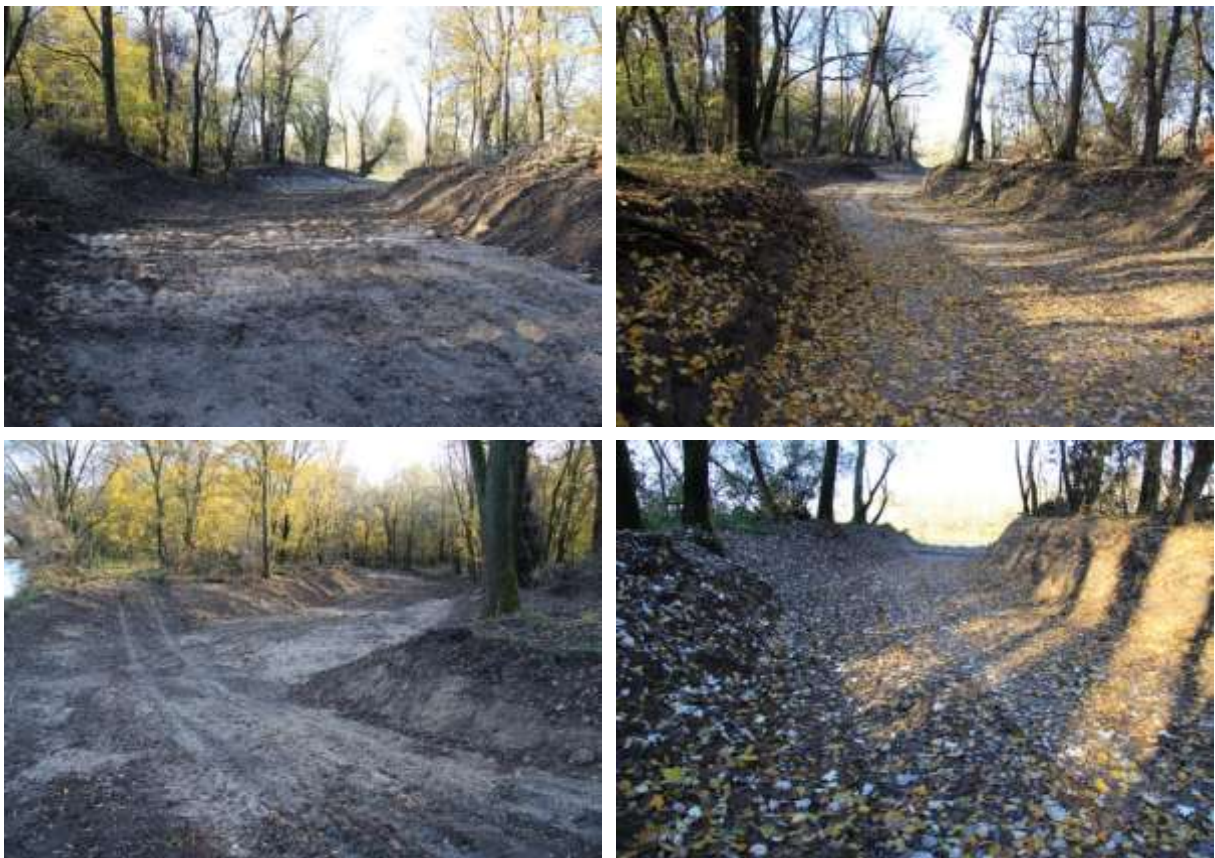
Abbildung 42: Aufnahmen des Nebenarmsystems Schanzl nach Bauumsetzung.
