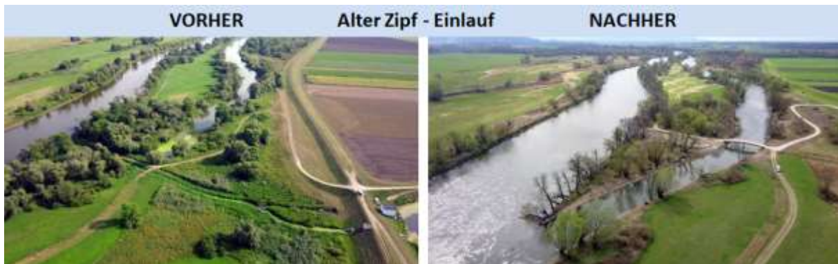
Abbildung 39: Aufnahmen vor (links) und nach (rechts) der baulichen Umsetzung
