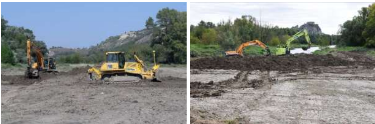
Abbildung 26: Bauarbeiten im Mündungsbereich
