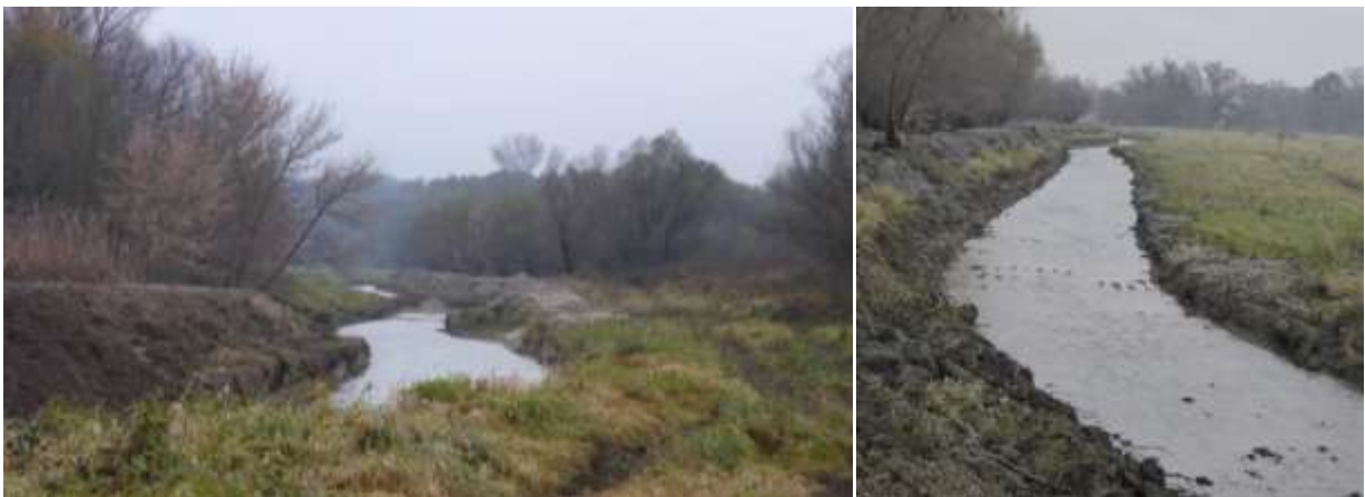
Abbildung 32: Herstellung eines neuen Seitenarms (Bereich 3) im Nebenarmsystem Markthofer Insel
