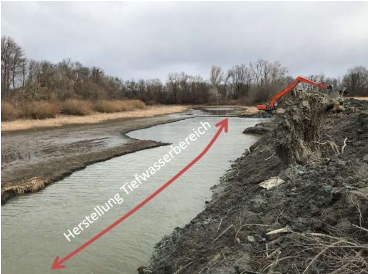
Abbildung 51: Baggerarbeiten mit Langstielbagger im Eisenbahnerteich.
