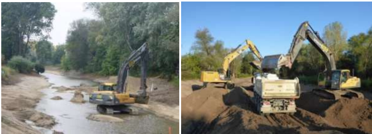
Abbildung 45: Aufnahmen von den Bauarbeiten im August 2015 im Altarm Angern.
