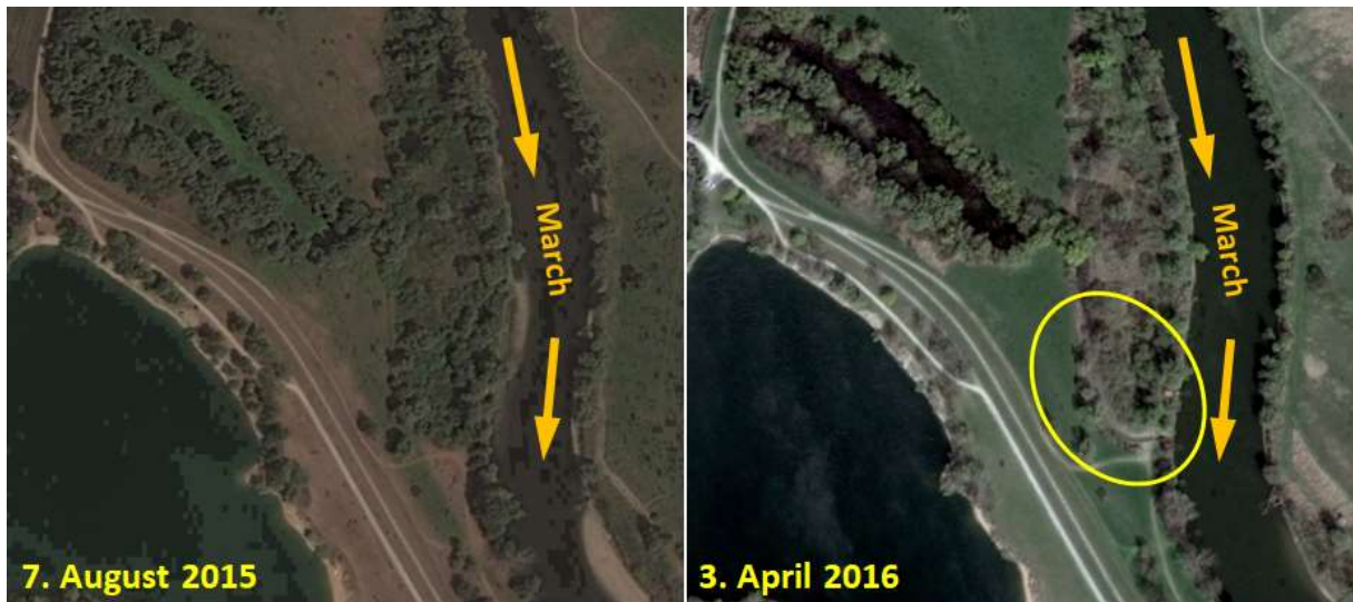
Abbildung 41: Luftbilder mit der Situation vor (links) und nach (rechts) Baggerung des Felbergrabens.
