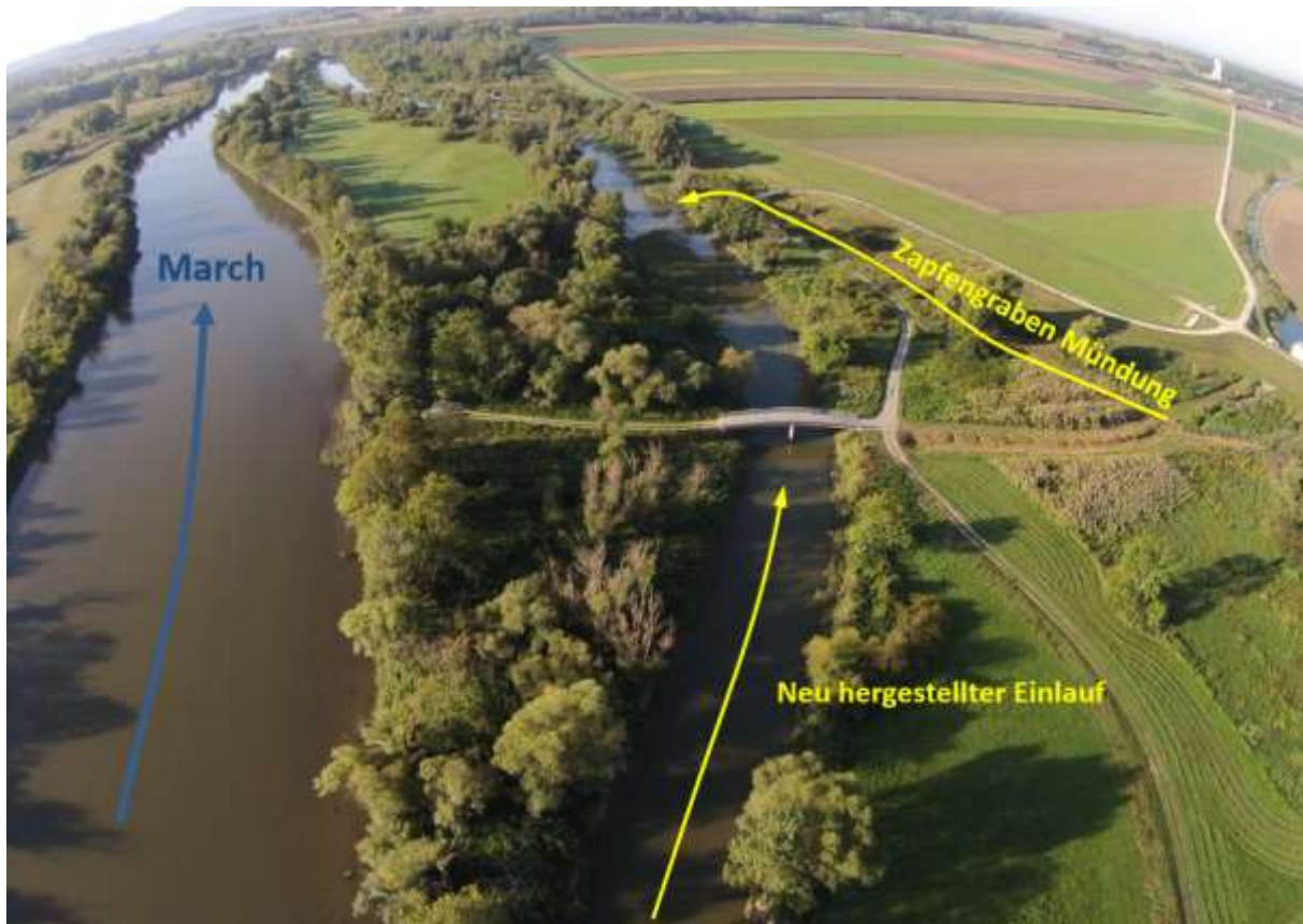
Abbildung 38: Aufnahme des fertigen neuen Einlaufbereichs des Alten Zipfs.
