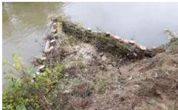
Abbildung 49: Ingenieurbiologische Maßnahmen im Hauptfluss, in Form von Dreiecksbuhnen um die Strukturvielfalt zu erhöhen
