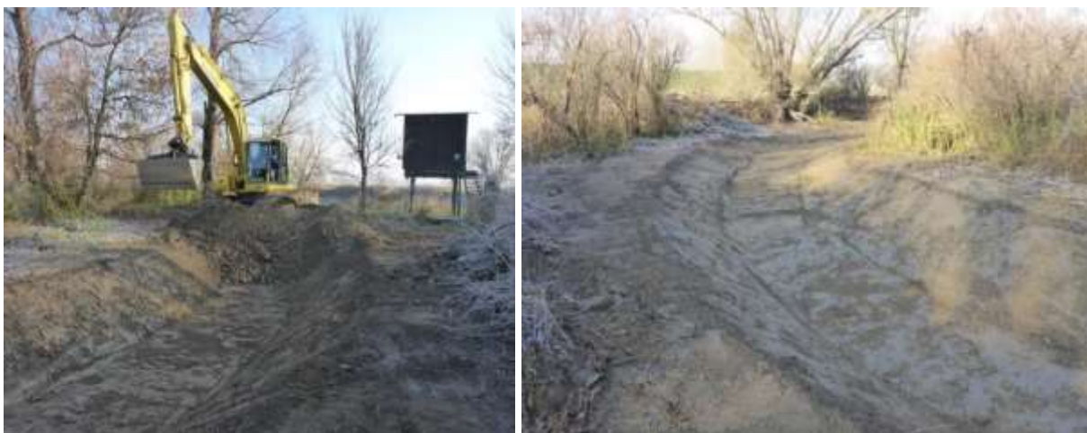
Abbildung 40: Dotationsgraben des Felbergrabens.
