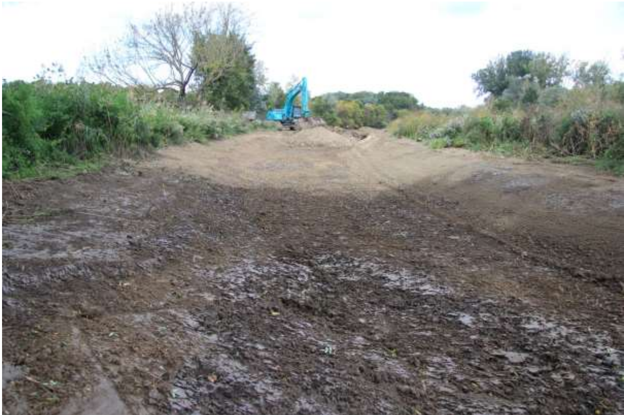
Abbildung 44: Zusätzlicher Einströmbereich in die Maritz
