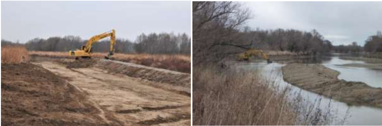
Abbildung 31: Entfernung von Anlandungen im Bereich 1 (links) und Bereich 2 (rechts)
