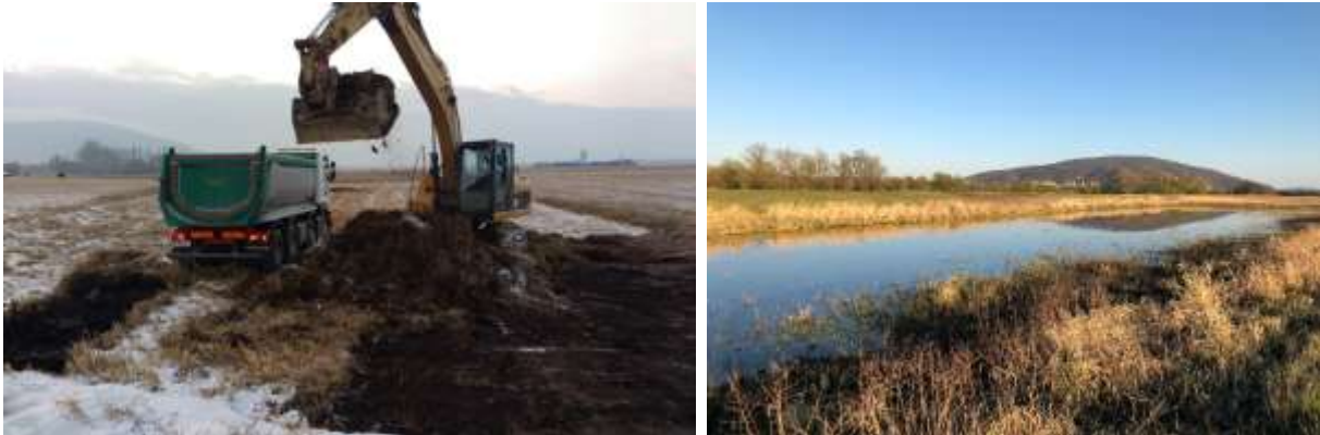
Abbildung 59: Das Ausbaggern der Suttien im Bereich der Langen Luss erfolgte im Winter (Frost). Dabei wurden insgesamt 3.400 m 2 Fläche auf max. 50 cm eingetieft. Die Wirkung zeigt sich besonders in trockenen Frühjahren sehr gut, da eine längere Wasserversorgung gewährleistet ist.
