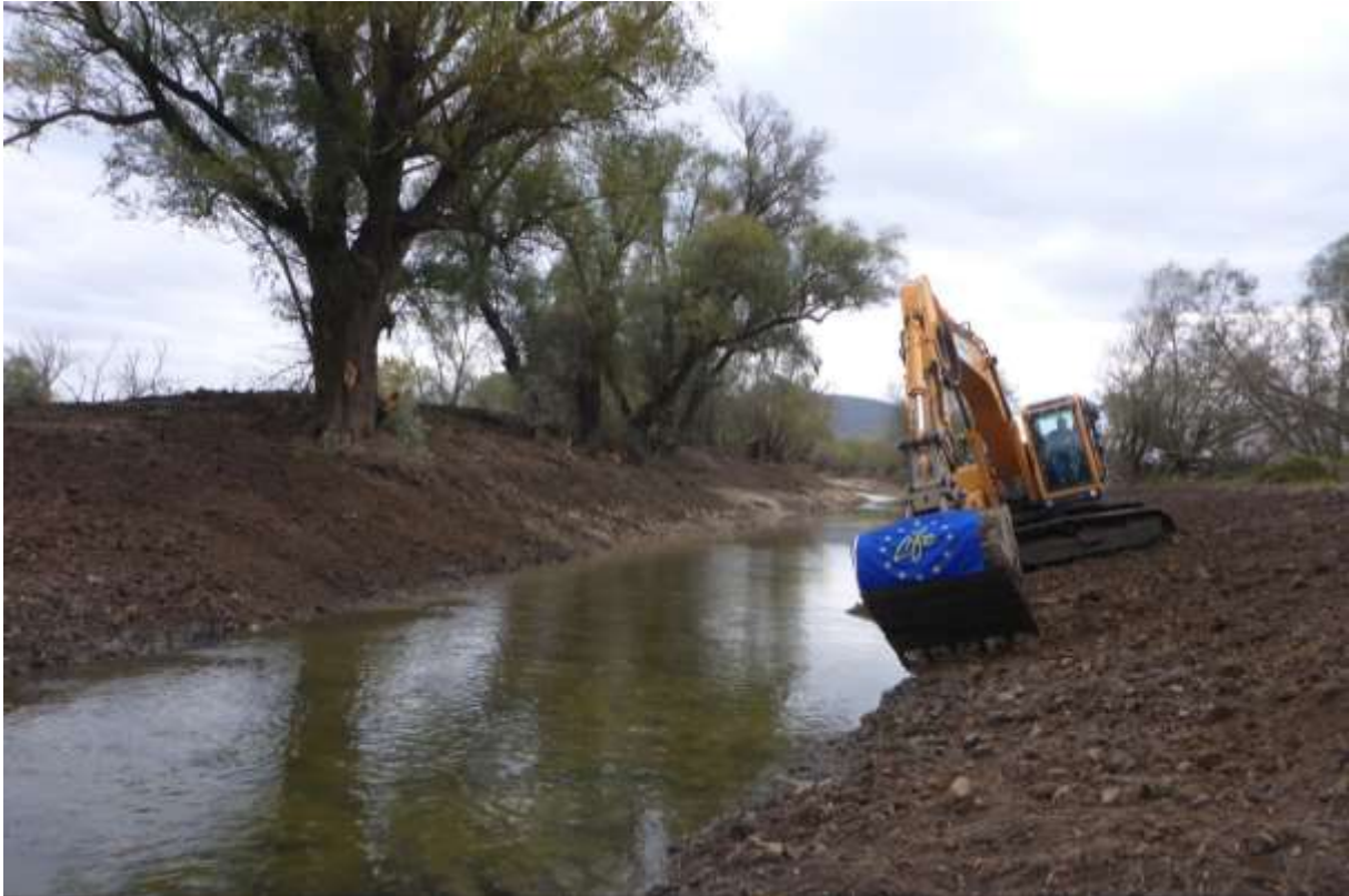
Abbildung 35: Einlaufbereich des neuen Seitenarms nach Fertigstellung.
