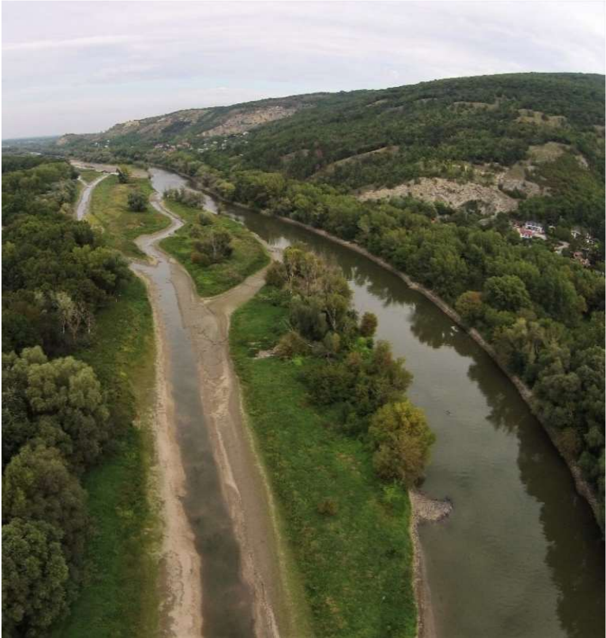
Abbildung 29: Aufnahme des renaturierten Mündungsabschnitts bei niedriger Wasserführung
