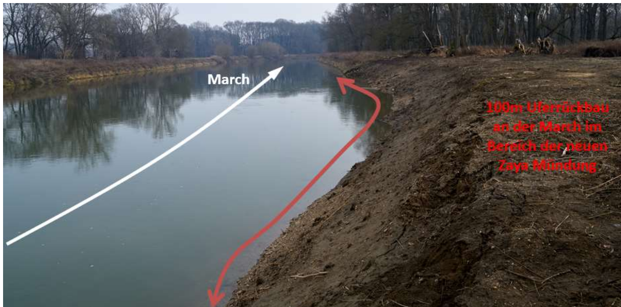
Abbildung 47: Uferrückbau an der March (Fluss-km 60,5 - 60,4)
