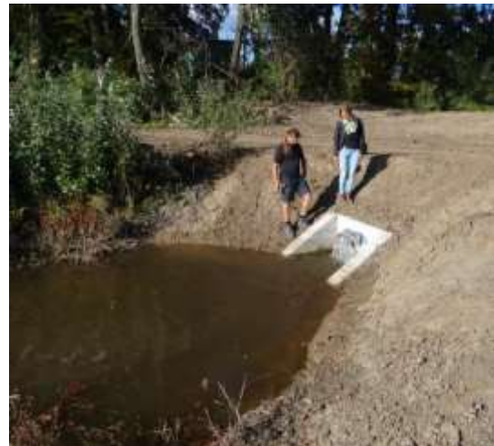
Abbildung 50: Überströmstrecke beim Eisenbahnerteich (linkes Bild) sowie Dotationsrohr beim Skodateich (rechtes Bild)
