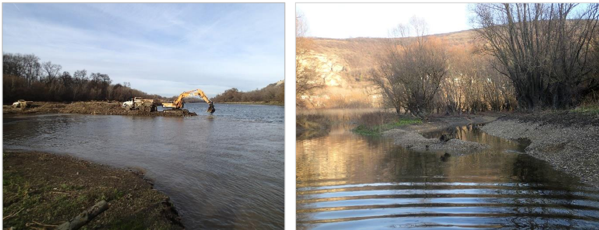
Abb. 1 Flussbauliche Maßnahmen im Unterlauf der March (links) sowie im Bereich der Stempfelbachmündung (rechts).
